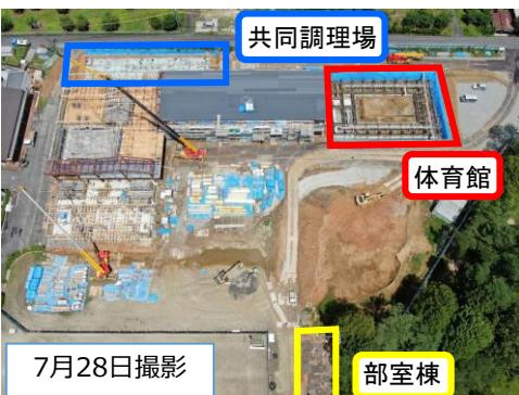
校舎棟部分の木工事が進み、2階部分まで柱が立ちました。8月下旬頃からは屋根工事が始まります。
