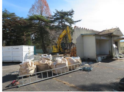
解体工事中の民俗史料館
