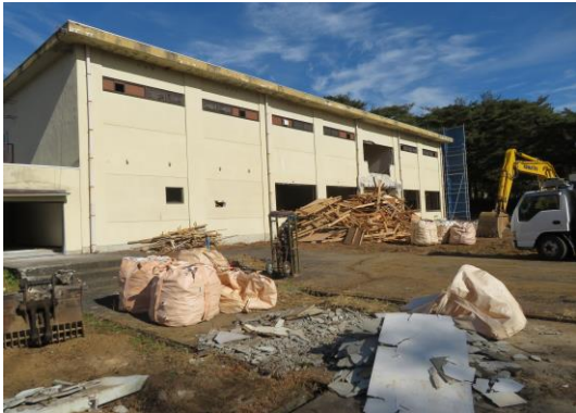
解体工事中の郷土資料館
